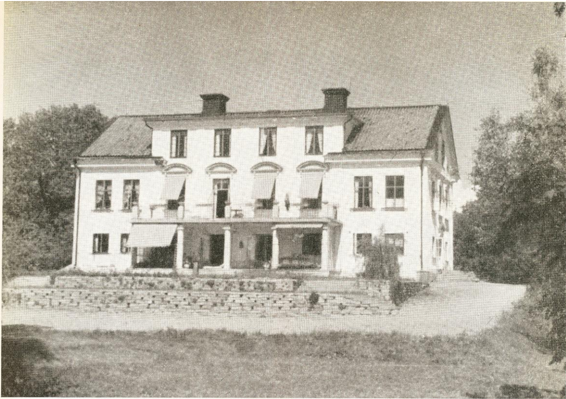
Broby huvudbyggnad uppfördes för nära 100 år sedan och har restaurerats tre gånger på 1900-talet.
