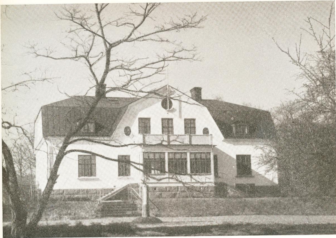
Alvastra gård räknar sina anor tillbaka till kung Sverkers tid. Den nuvarande huvudbyggnaden uppfördes år 1905.
